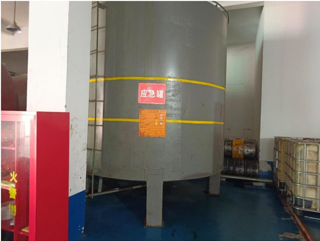
图 4.1-5 事故应急罐照片
