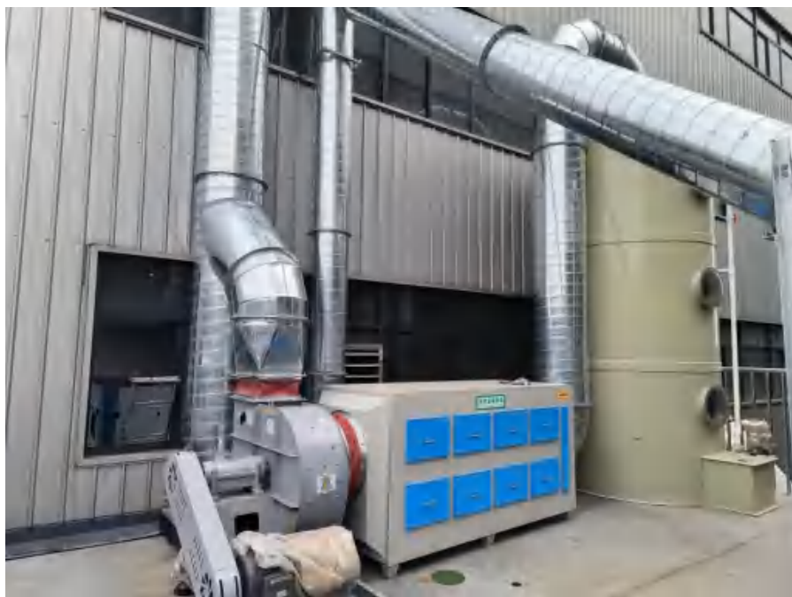
图 4-2.1 压铸废气处理设施照片
