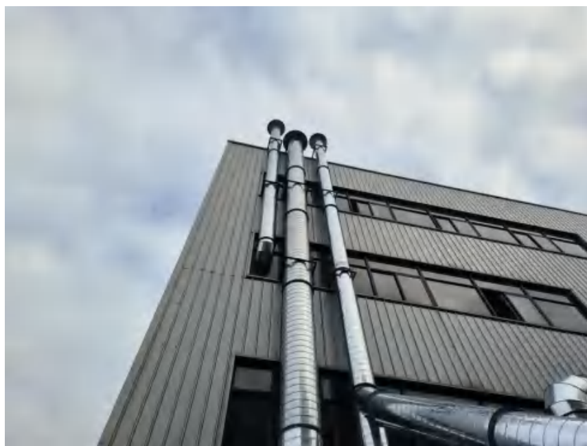
图 4-2.7 排气筒照片
