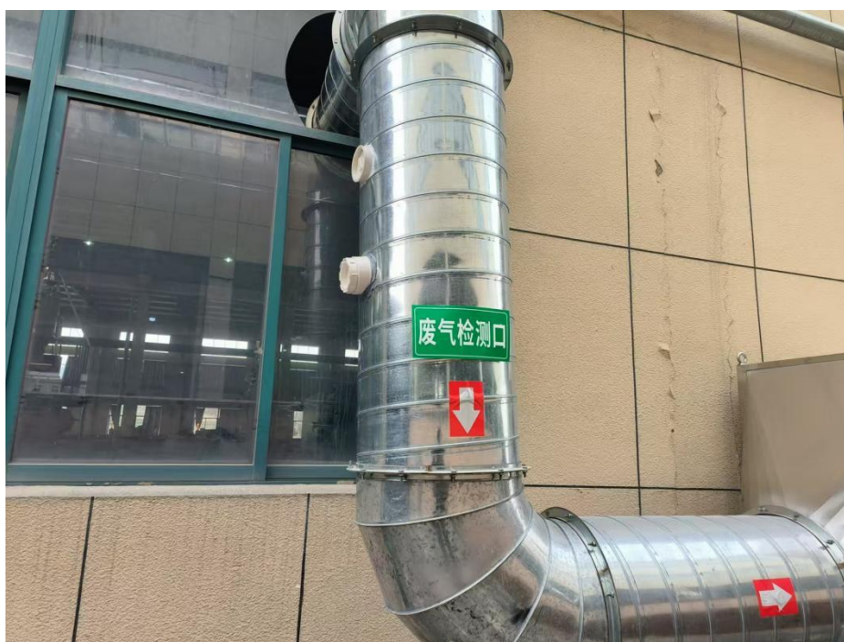
图 4-2 塑料废气检测口照片
